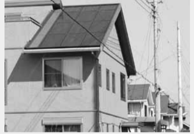
補助制度を利用して設置された太陽光発電設備
