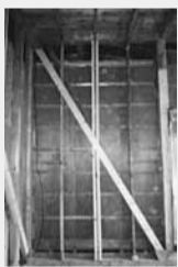
壁に筋交いを追加して補強した耐震改修の例
