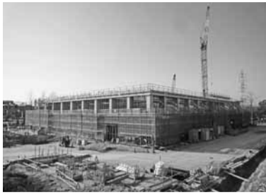
工事が進む市民総合体育館
