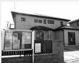
外壁工事を行った、ときわまつ自治会大貫会館
