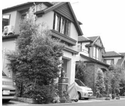
グリーンチェーン認定を取得した戸建て住宅
