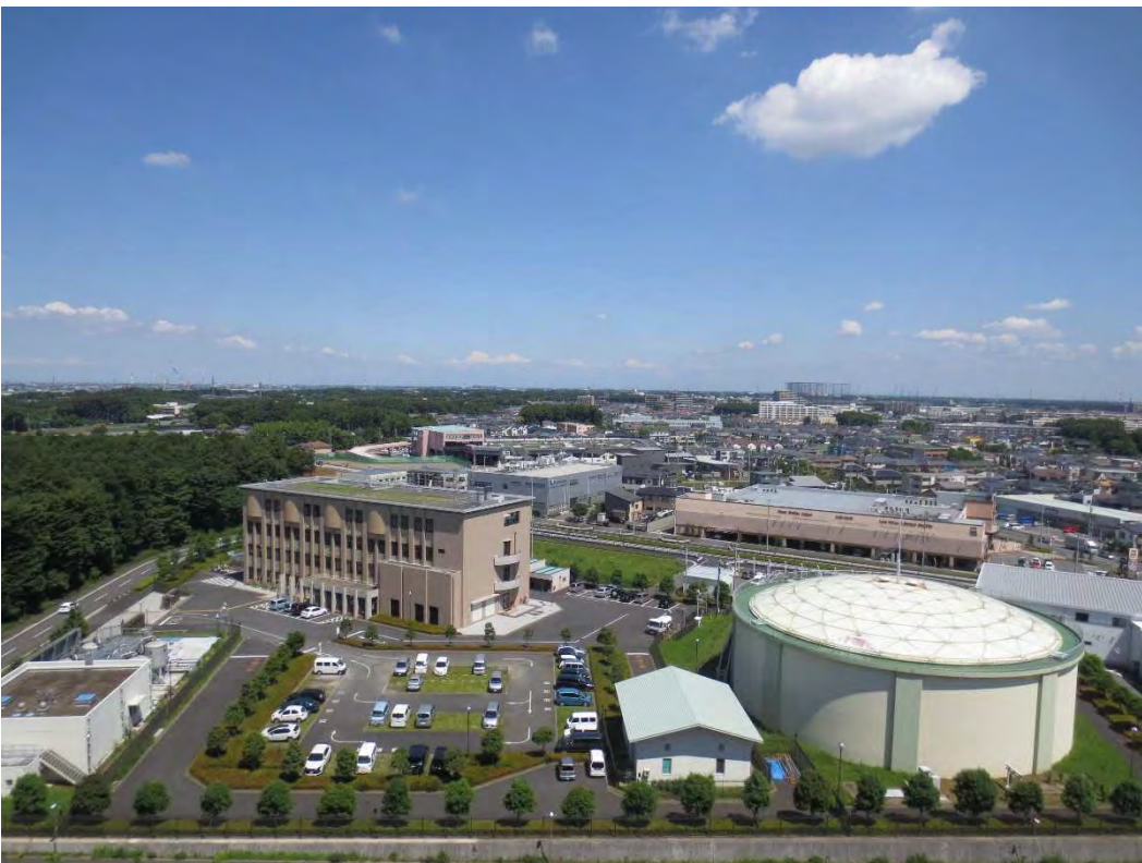
おおたかの森浄水場全景
