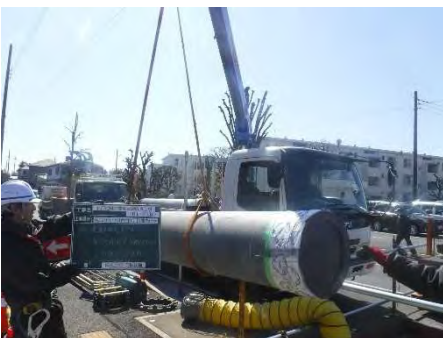
基幹管路の建設
