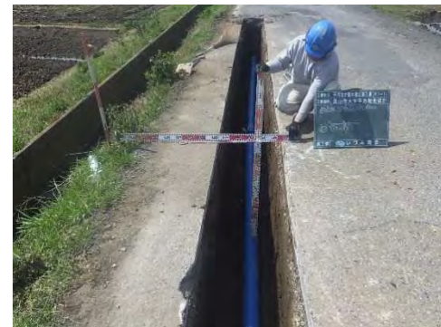
配水管の設置
