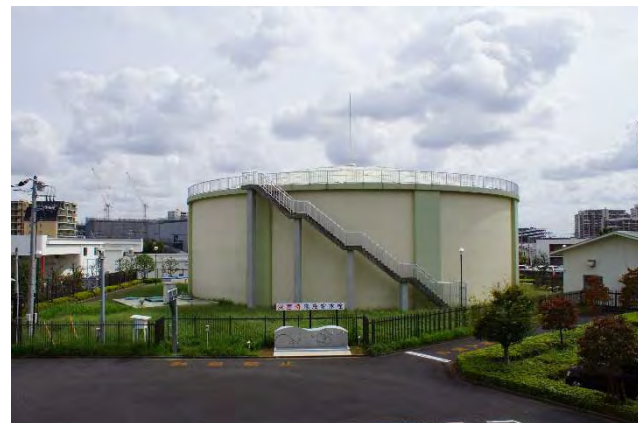
配水池（配水タンク）
