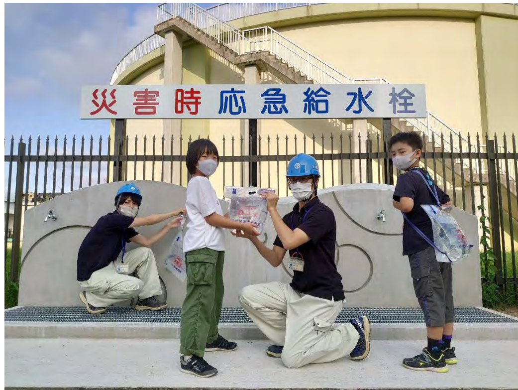
応急給水栓（おたかの森浄水場）
