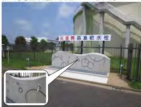
図 2 おおたかの森浄水場の応急給水施設
