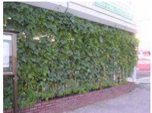
図 7-12 壁面緑化の導入状況(西平井・鰯ヶ崎地区区画整理事務所)
