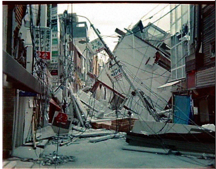
阪神・淡路大震災で倒壊したビル
