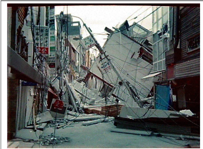
阪神・淡路大震災で倒壊したビル
