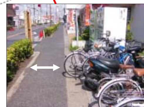
植栽がある部分は有効幅員 2m とれていない。自転車のはみ出し
