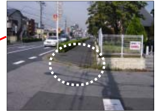
枝道との交差部の歩道の段差が大きい
