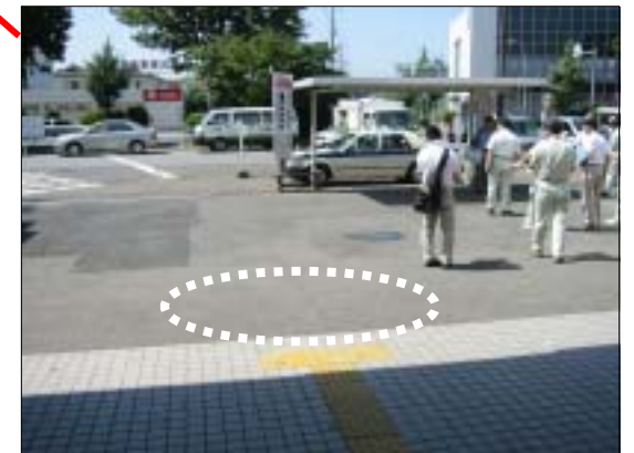
駅前広場には誘導ブロックなし バス乗り場が分かりにくい(サインの不足)
