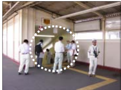
階段には2段手摺、誘導ブロックが設置されている
