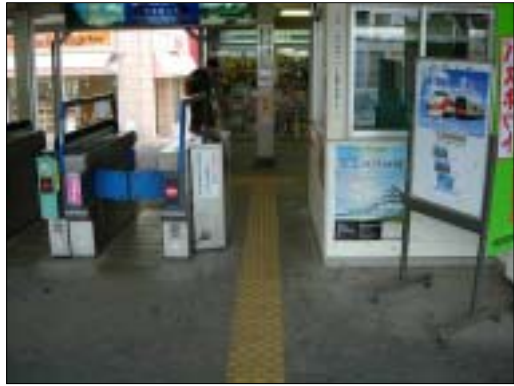
誘導ブロックが設置されている
