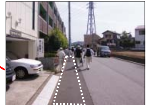
歩道が整備されていない
