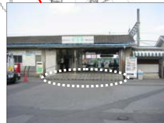
駅前広場に歩道がない 駅舎手前に段差がある
