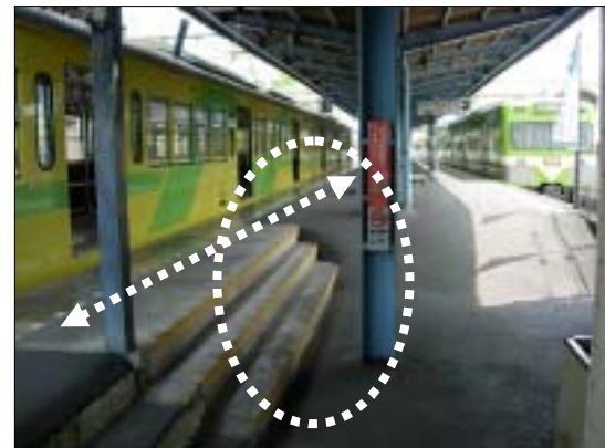
誘導ブロックの整備なし 手すりもなし
