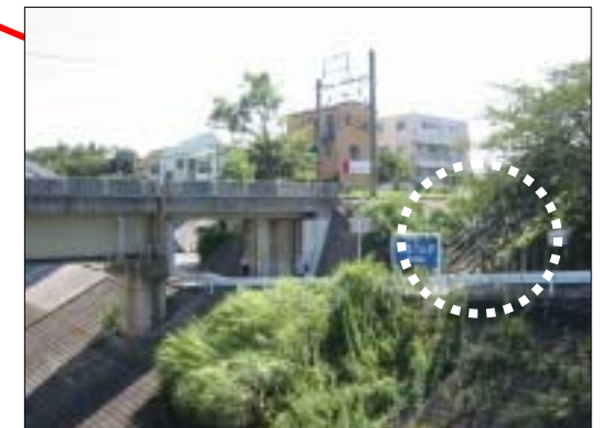
ふれあい橋側は、階段段差あり
