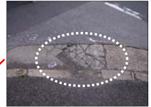
交差点隅切り部の現場打ちコンクリートが老朽化。不陸を生じている
