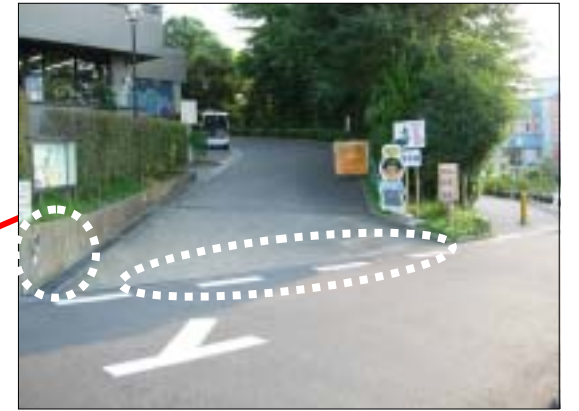
施設出入口の勾配がきつい インターホンの位置が遠く、足元に グレーチングがあり押しづらい
