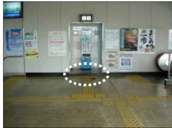
トイレ内の段差
