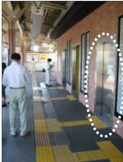
バリアフリー対応トイレが設置されている
