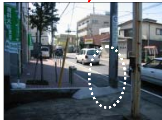
一部歩行空間あり 電柱等が歩行空間を狭めている
