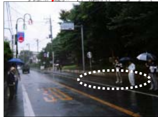
歩道の切り下げがない箇所があり、車いす利用者が道路を横断できない
