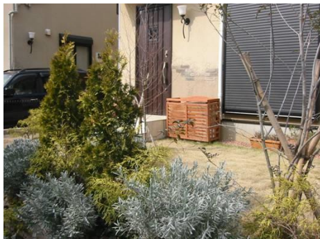
建築物の外観デザインと調和した囲いでエアコンの室外機を覆い、目立たなくなるように工夫しています。
