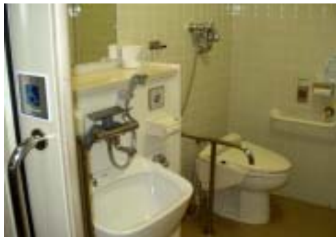
オストメイト対応トイレ設備整備事業 (市役所第一庁舎一階の多目的トイレ/オストメイト対応)
