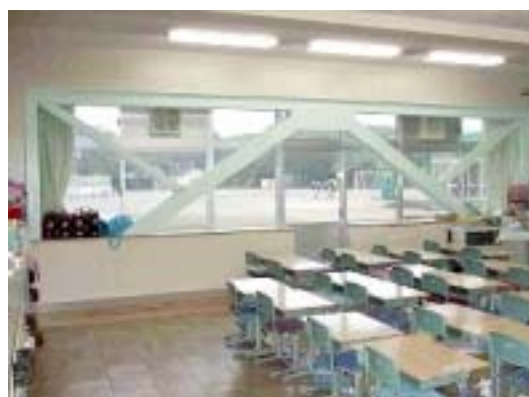
小学校学校建物耐震改修事業 (東小学校校舎耐震補強工事)
