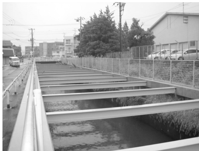
川幅を広げ、川底を下げ改修が終わった河川（神明堀）
