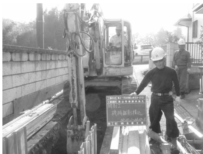
生活道路上で行われる公共下水道工事
