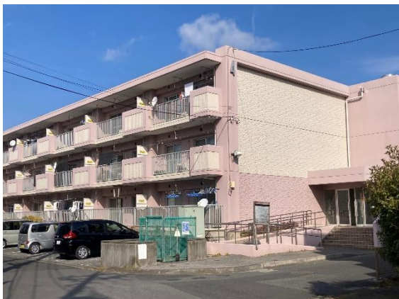
令和7年度に屋上の防水改修工事を 予定している大橋団地
