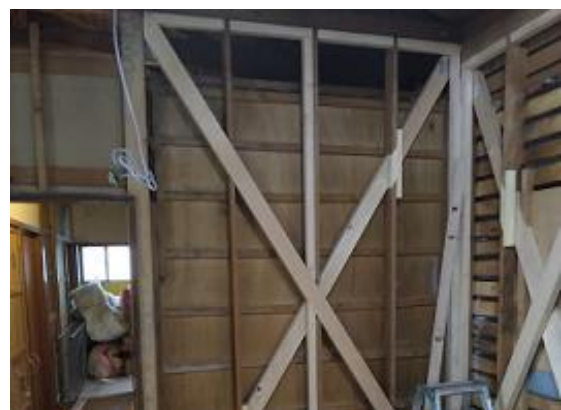
住宅の耐震改修工事
