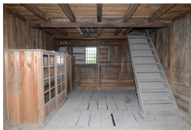
修復工事を行う国登録有形文化財「秋元家住宅土蔵」の建物内部
