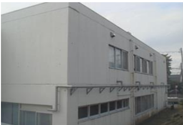
令和7年度塗装する江戸川台福祉会館の外壁
