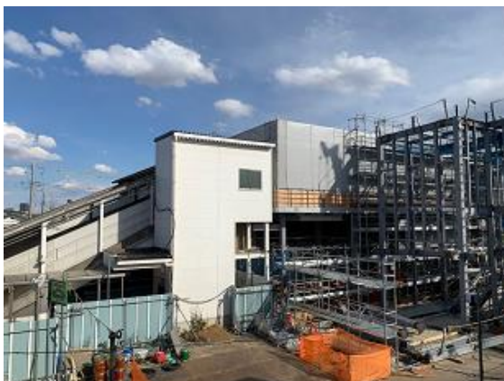
初石駅橋上駅舎・自由通路整備工事
