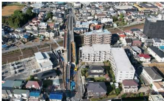
上空から見る名都借跨線橋
