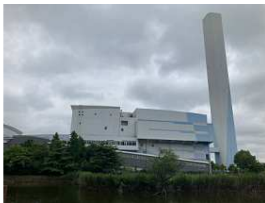
延命化を行うクリーンセンター
