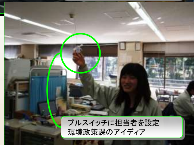
LEDベースライト：市役所本庁舎 ※DB型バルクESCOによる ※1本ごとにプルスイッチ管理
