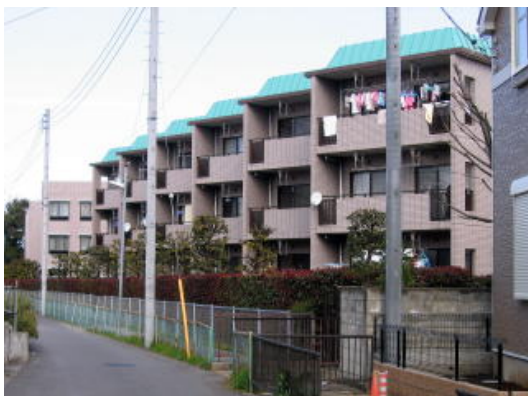
瀟洒な社宅(住宅地区B)
