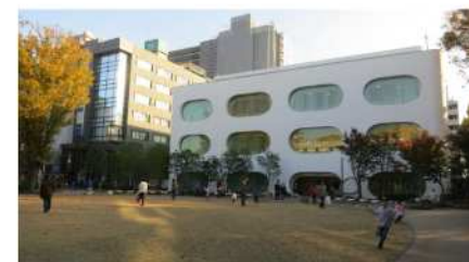
公共施設と一体的に計画された駅前空間のイメージ例（武蔵境駅南口駅前）
