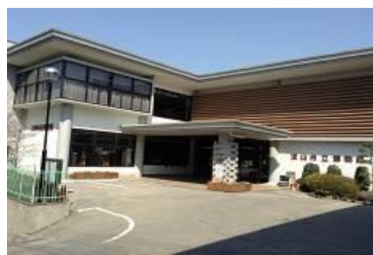
流山市立博物館(工事完了後)
