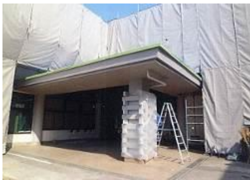
流山市立博物館(工事中外観)
