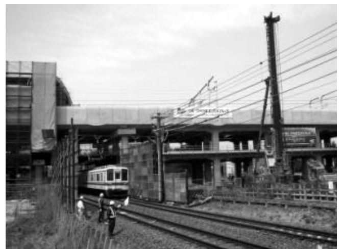
《中部地域：流山おおたかの森駅の工事の様子》
