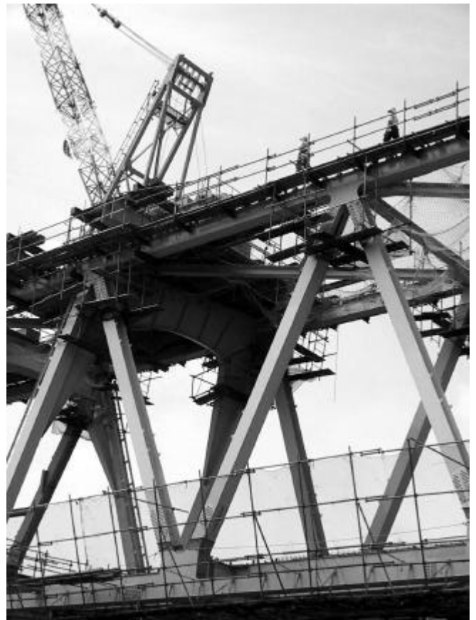
《中部地域：つくばエクスプレス工事の様子(江戸川)》
