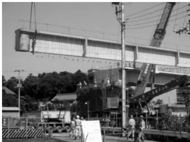
《中部地域：つくばエクスプレス工事の様子(市野谷)》
