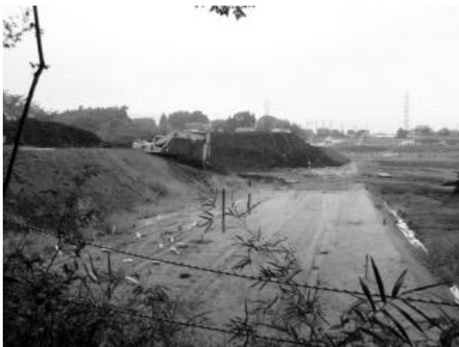
《南部地域： 道路の設置の先端が斜面緑地の伐採へと進む姿》
