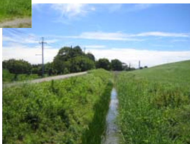
農村風景と調和した水路の修景を行います。
