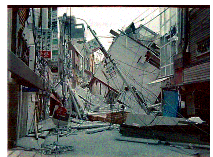
阪神・淡路大震災で倒壊したビル
