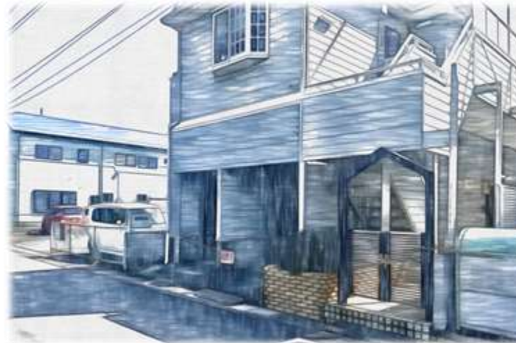
老朽化しつつある建物
