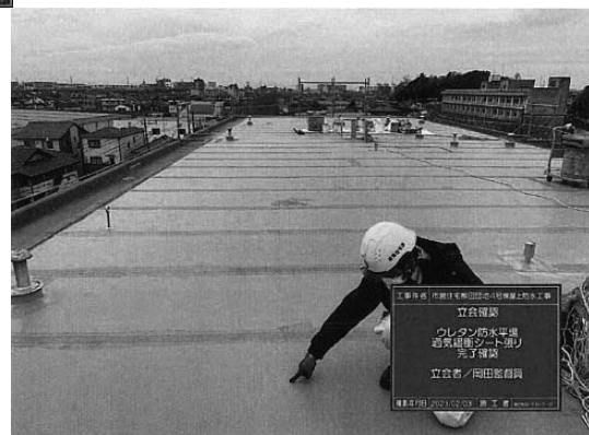
市営住宅柳田団地4号棟屋上防水改修工事
