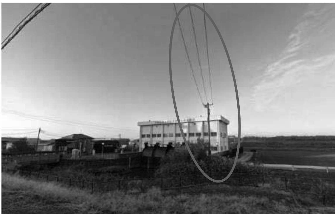
流山排水機場の現状（既存の電線に加えて、別ルートからの供給ルートを整備する。）
