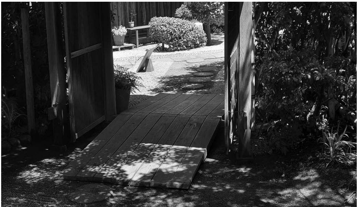
車椅子対応のスロープ設置
