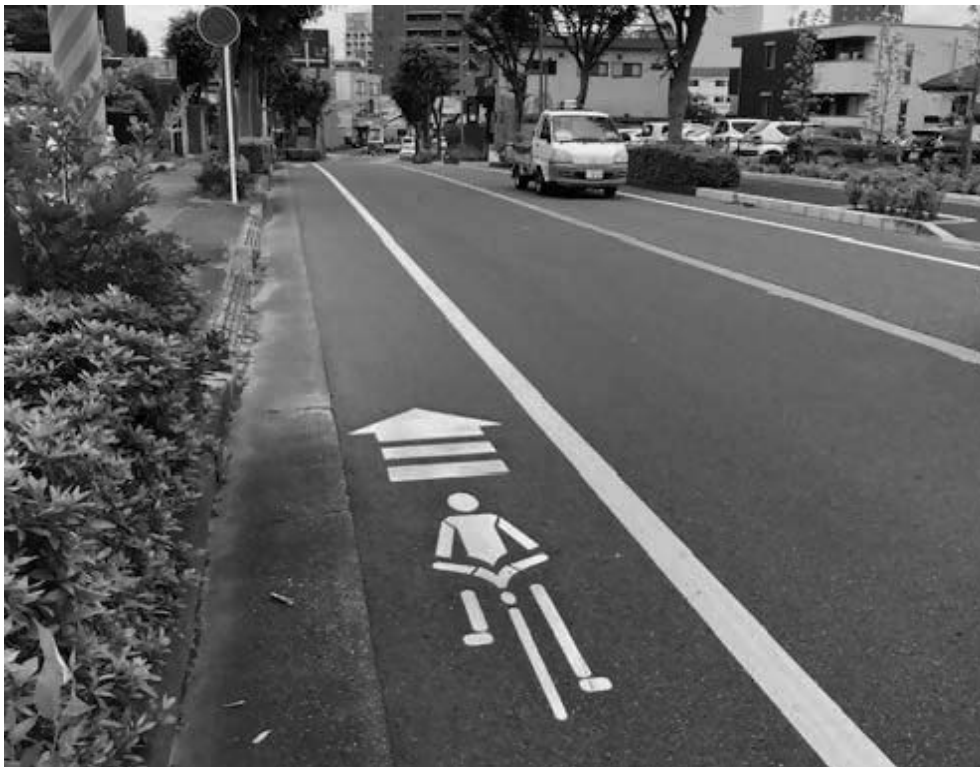
自転車通行空間を一部整備（都市計画道路3・4・9号南流山名都借線）
