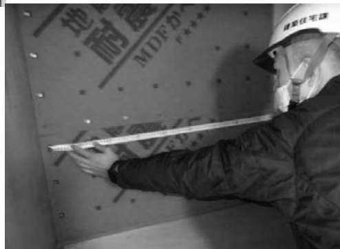
耐震改修工事及び耐震改修工事の中間検査の様子
