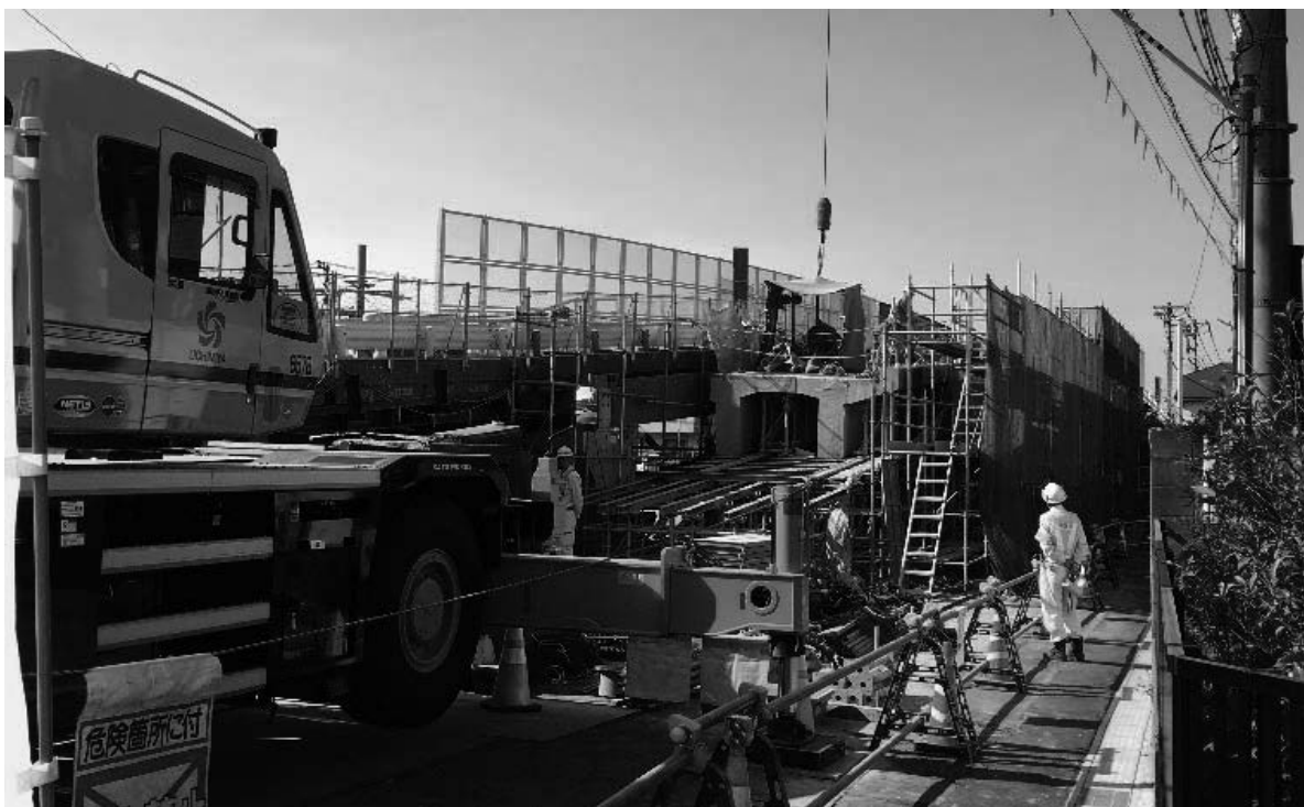
既設橋撤去状況（向小金2丁目側）
