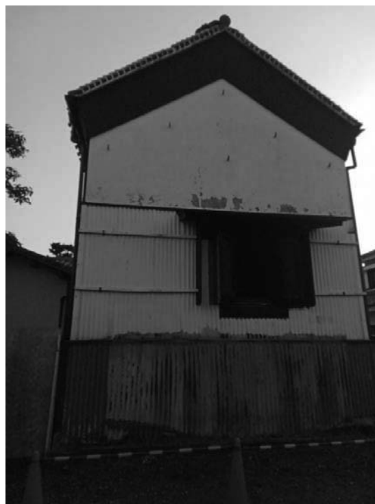
国登録有形文化財秋元家住宅土蔵保存修復工事
