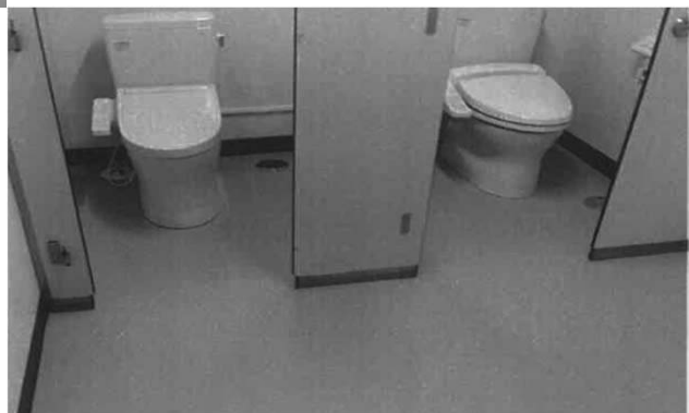
東部公民館と改修後の女子トイレ
