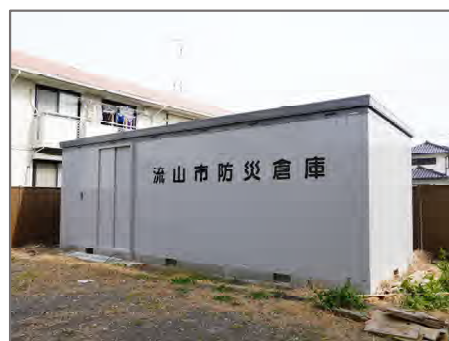
小学校の備蓄倉庫
