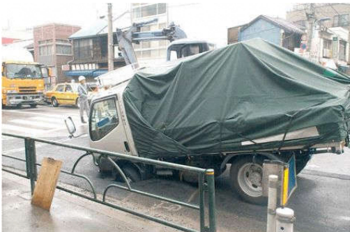
道路陥没事故事例（東京都）
