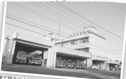
建て替えにより訓練用バルコニーなどを備えた南消防署
