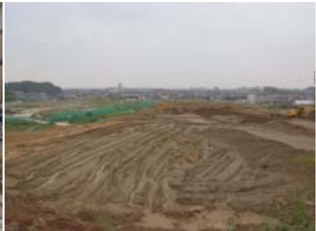
整理中の状況
