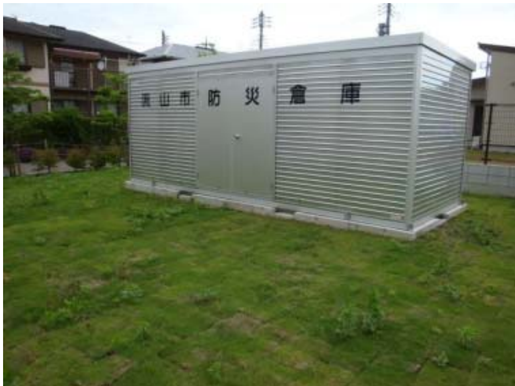
加1丁目地先の防災備蓄倉庫
