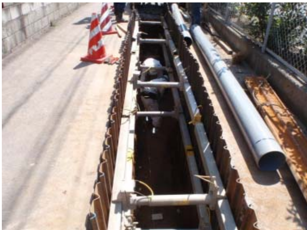
開削工事の様子
