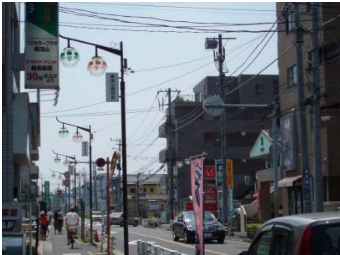
南流山商店街の省電力街路灯
