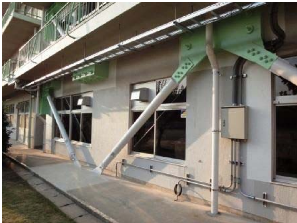
耐震改修後の常盤松中学校校舎
