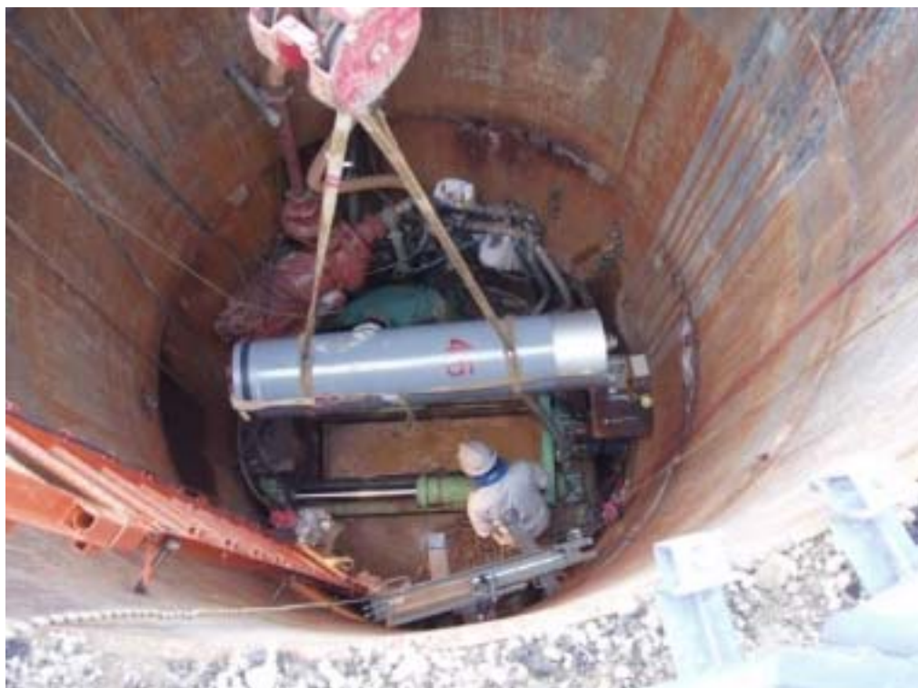
推進管設置の様子
