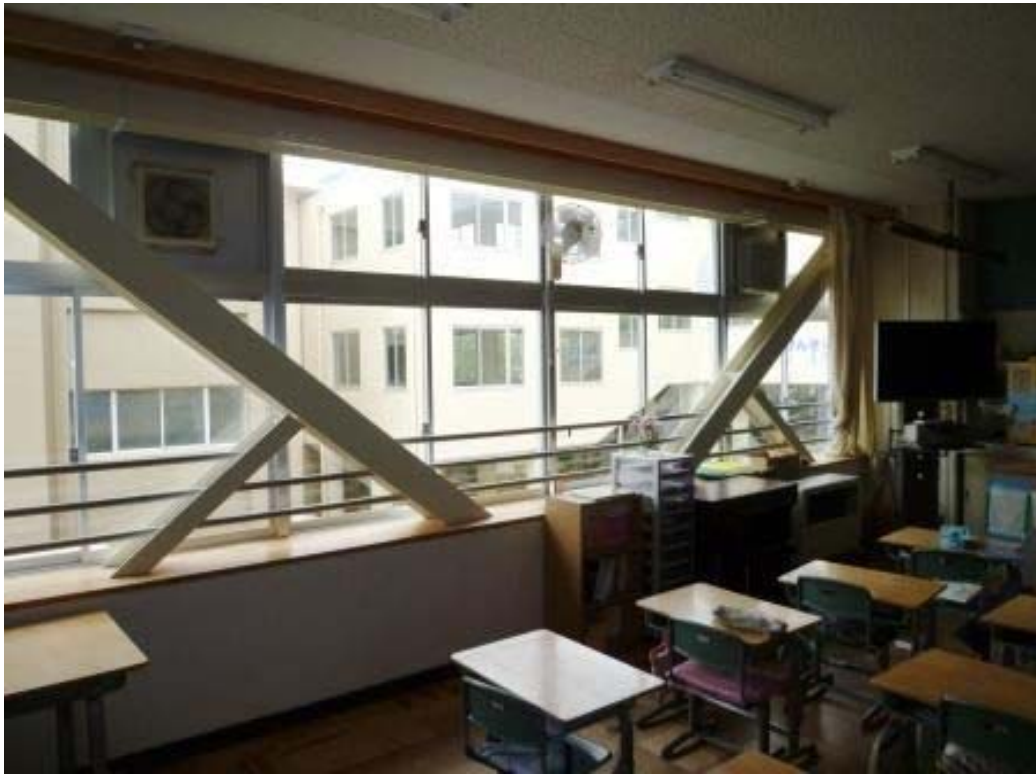
耐震改修後の八木北小学校校舎
