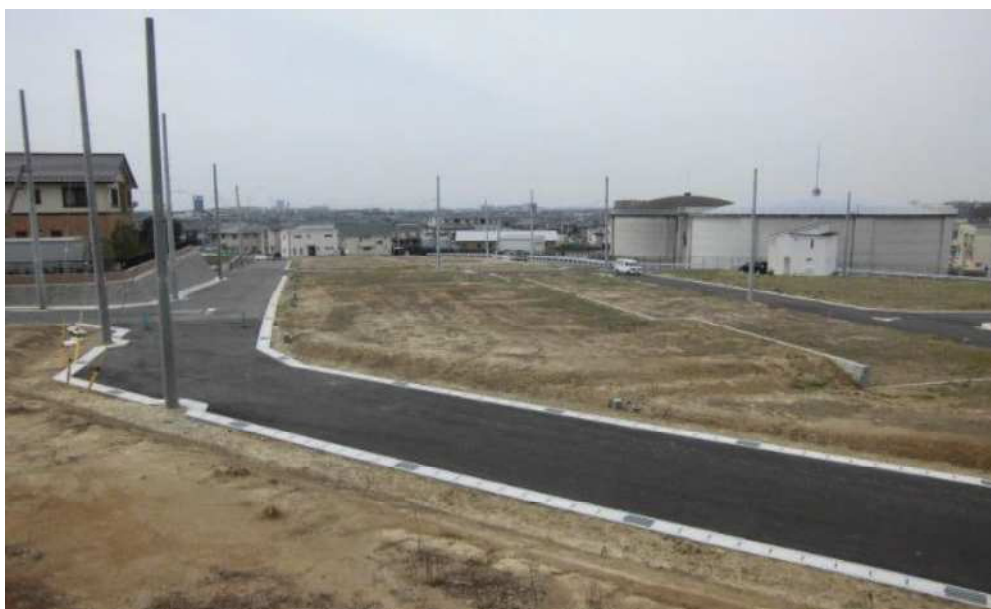
完成した宅地及び区画道路
