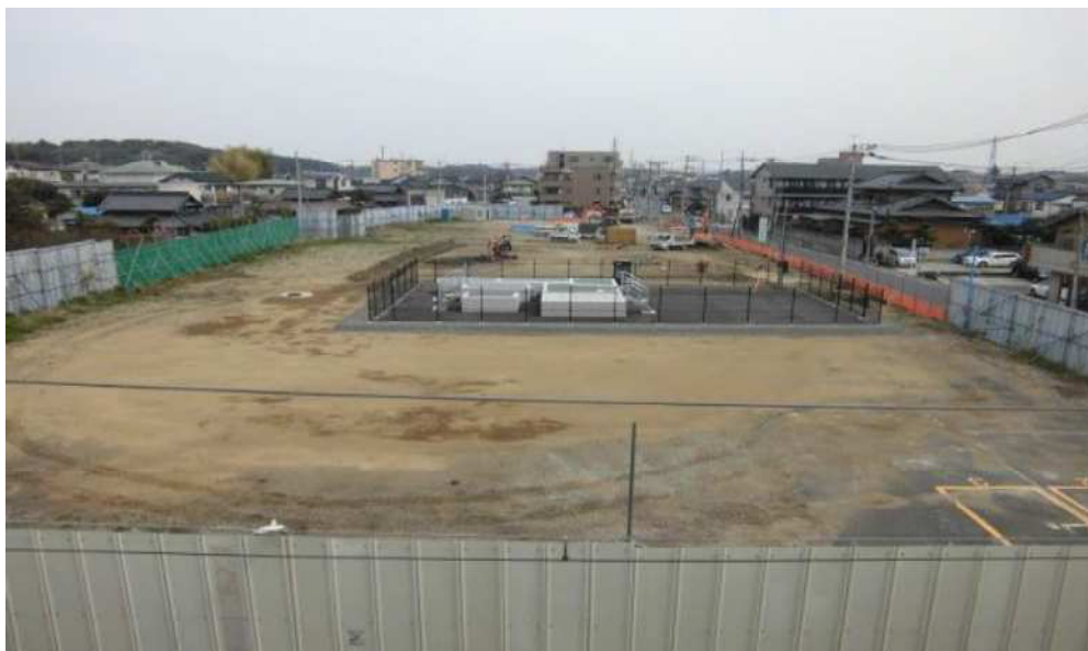
完成した鱒ヶ崎調整池（地下式）
