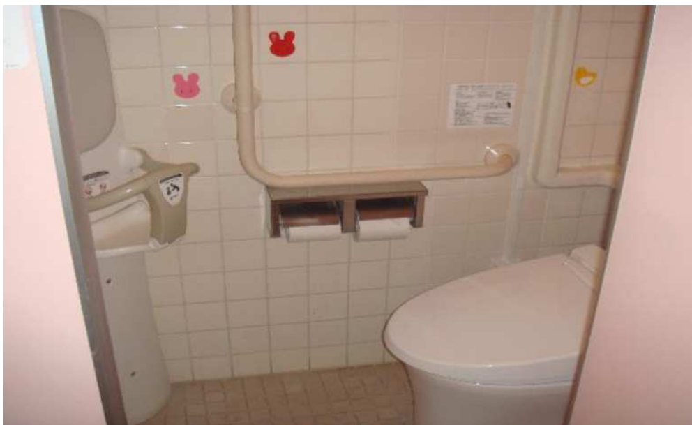
駒木台福祉会館トイレ改修
