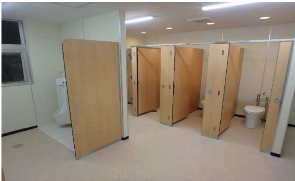
西初石中学校トイレ改修工事後
