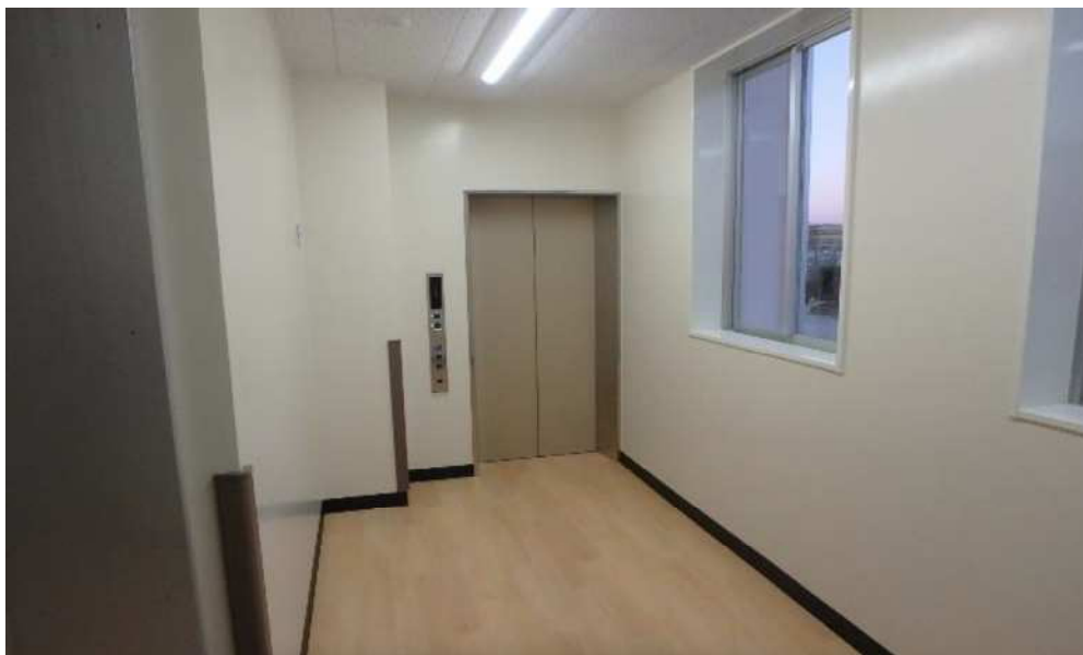
西初石中学校エレベーター設置工事後
