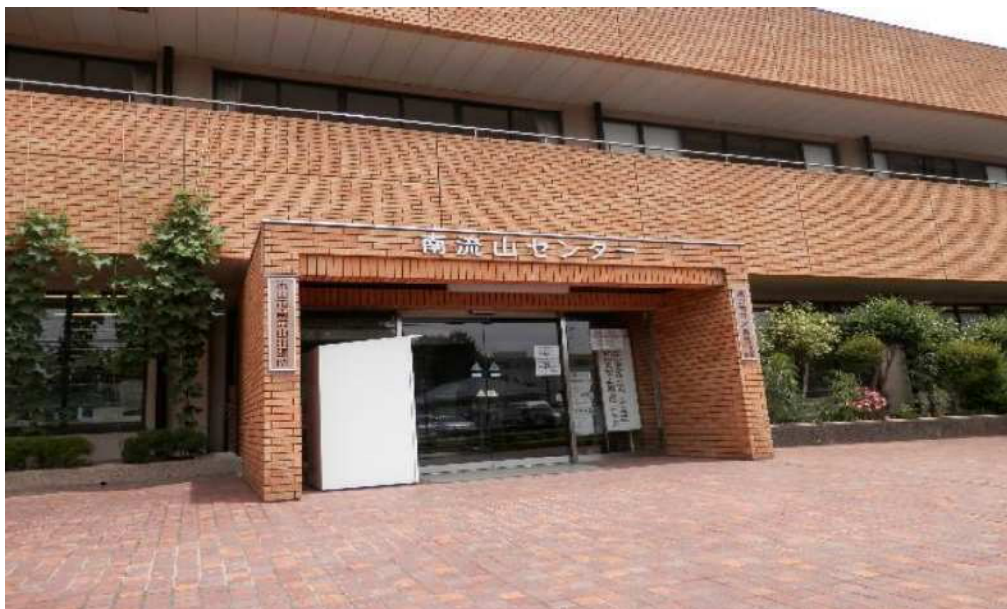
外壁改修を終了した南流山センター
