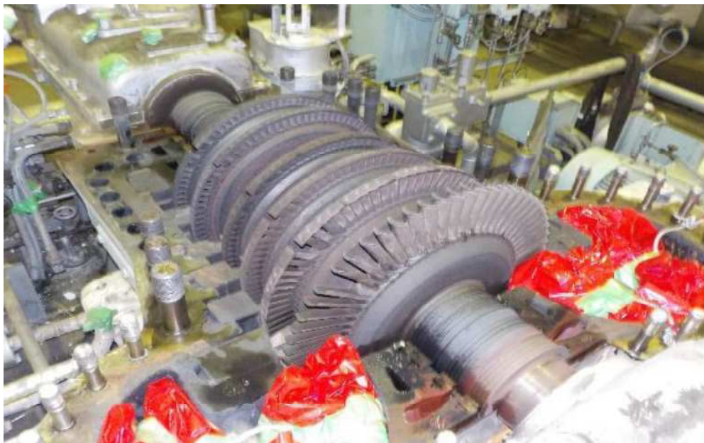
蒸気タービン整備の様子
