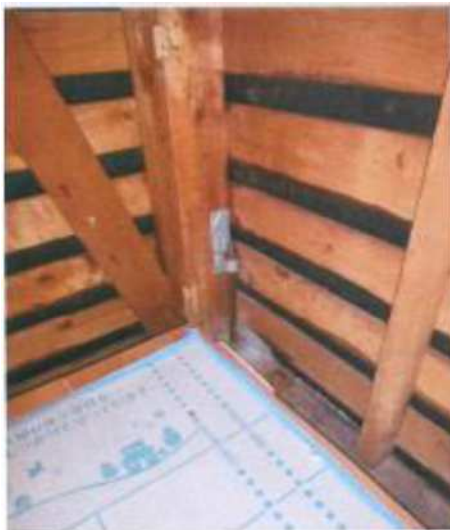
木造住宅に耐震補強を施工した状況
