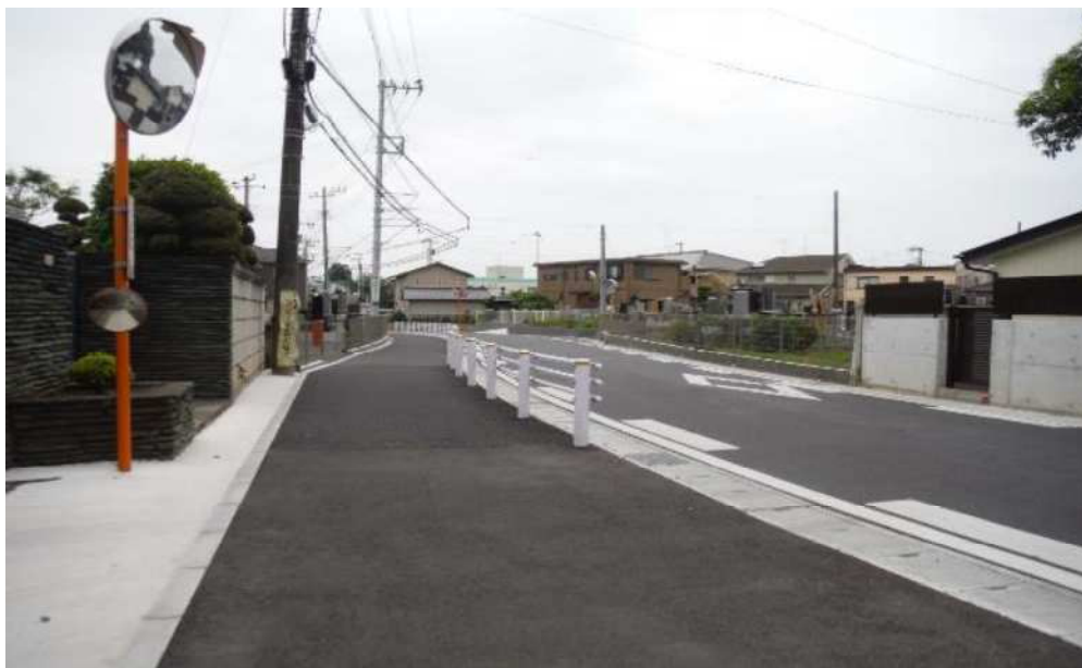
市道前ケ崎・向小金1号道路拡幅事業
