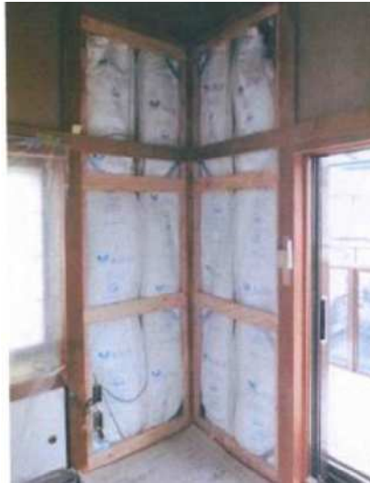
木造住宅に耐震補強を施工した状況
