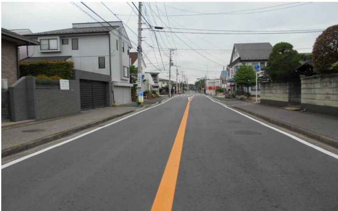
補修後の東深井・江戸川台西幹線
