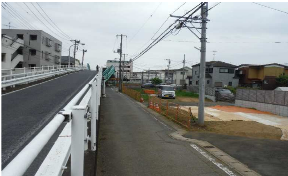
名都借跨線橋道路拡幅改廃事業
