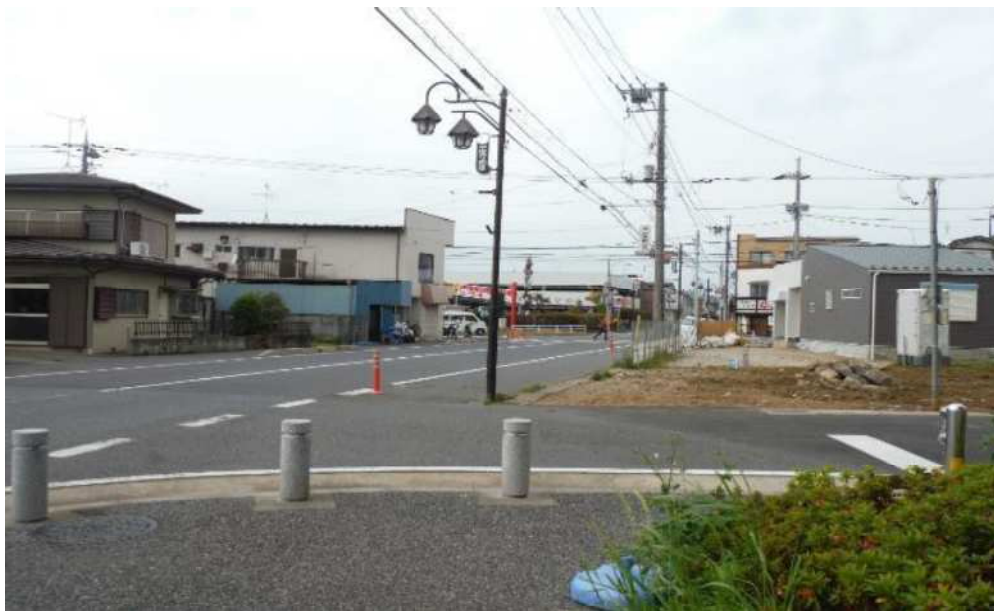
都市計画道路3・5・16号三輪野山西平井線道路改良事業
