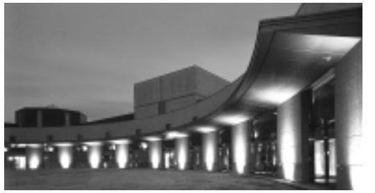
充実した設備のウイングホール柏斎場
