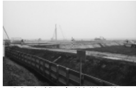
造成工事が進むごみ焼却施設用地
