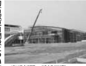
東武新駅の建設工事
