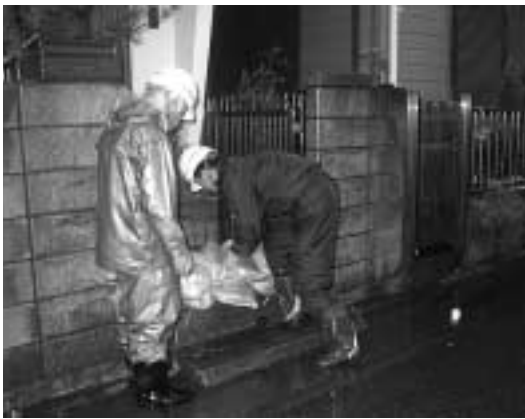
浸水に備えて積まれる土のう
