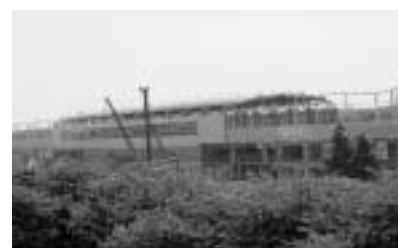
工事が進む流山おおたかの森駅
