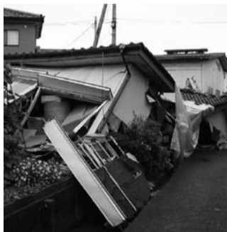
新潟県中越沖地震による被害
