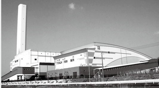
平成16年2月に竣工したごみ焼却施設
