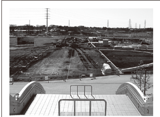
造成中の流山おおたかの森駅南口(平成18年2月)
