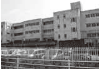
工事が行われる流山北小学校
