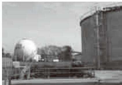
工事中の江戸川台浄水場
