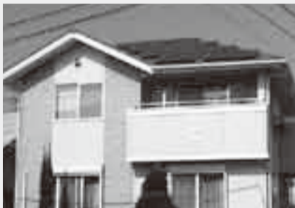
屋根に設置された太陽光パネル
