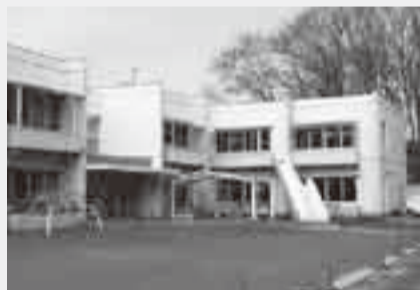
床補修が行われる東深井保育所
