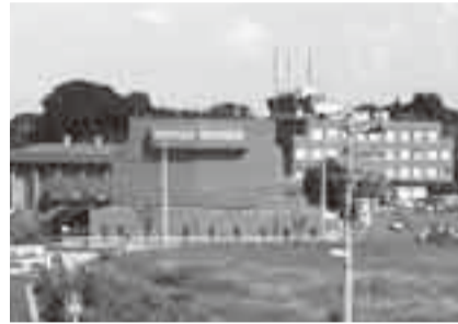
流山セントラルパーク駅前の生涯学習センター
