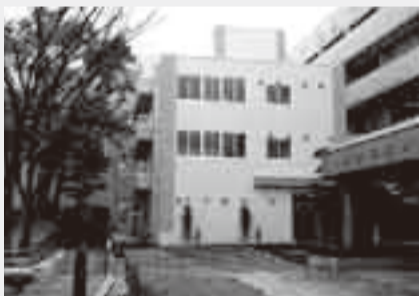
市役所の新第2庁舎
