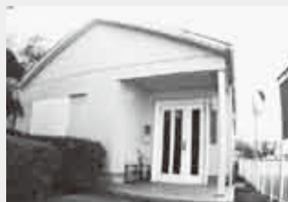
大規模修繕が行われる自治会館
