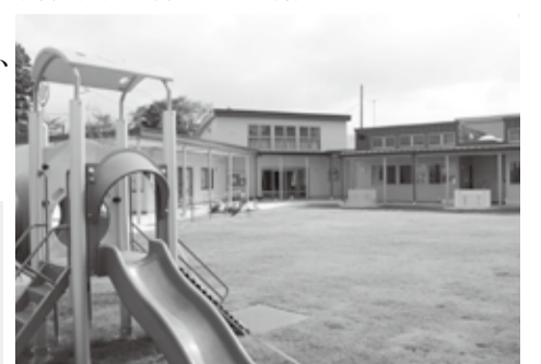
完成した園舎
