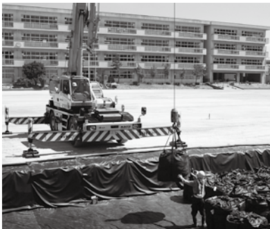
中学校の除染の様子
