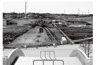
造成中の流山おおたかの森駅南口(平成18年2月)
