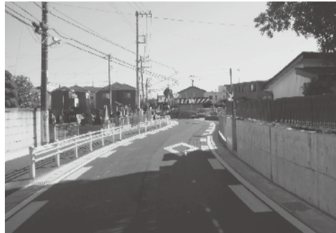
拡幅整備が完了した市道前ヶ崎・向小金1号道路
