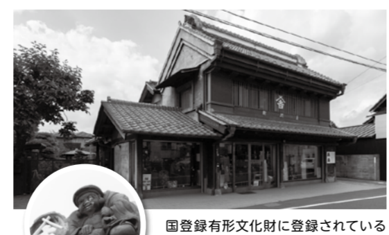
国登録有形文化財に登録されている土蔵造りの建物。南側には大黒天、北側には恵比寿がやさしいほほ笑みで鬼瓦に鎮座
