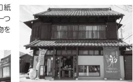
築約80年の建物を改装した店構えが和紙照明にマッチ
