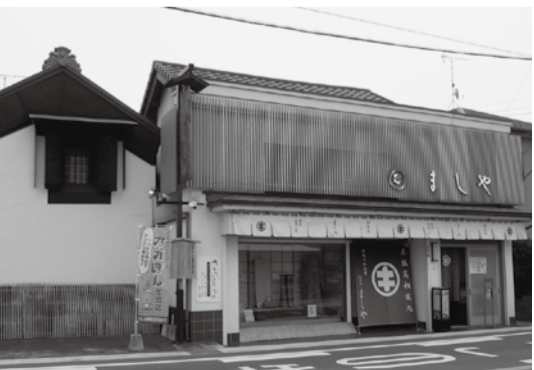
「呉服ましや土蔵」は明治期の土蔵造りの様子を随所に残す建造物として流山市指定有形文化財に指定
