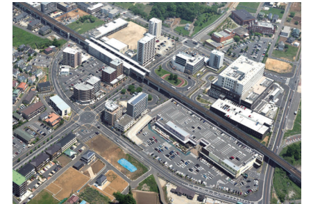
安心安全に欠かせないインフラ整備
