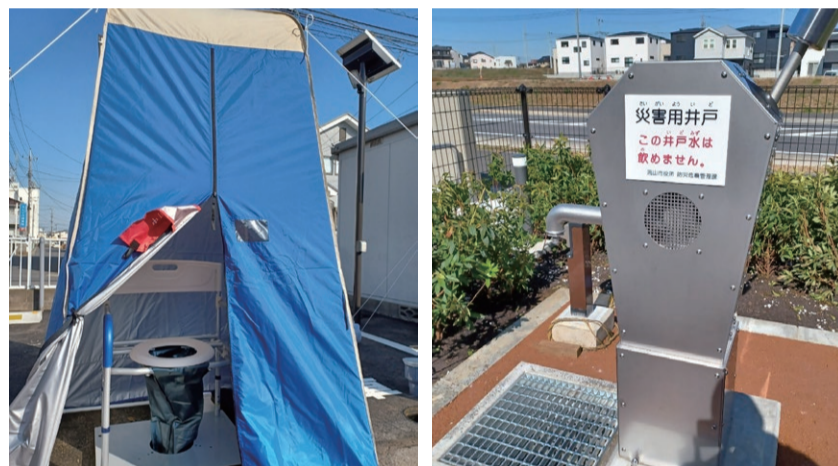
昨年度整備した北部公民館のマンホールトイレ(左)と市野谷小学校の災害用井戸(右)
