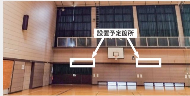
エアコン設置予定のコミュニティプラザ体育室
