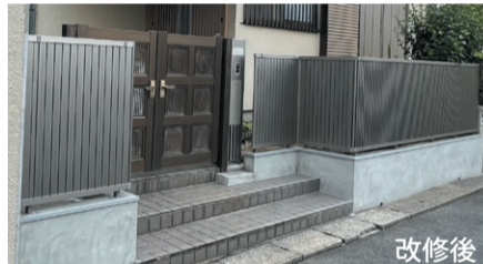
コンクリートブロック塀の改修例
