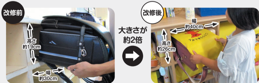
A4教科書対応になったランドセルが入るよう改修したロッカー
