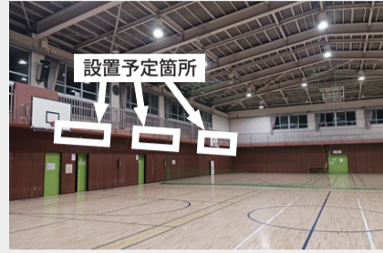
エアコン設置予定の体育館
