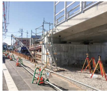
拡幅工事が進む名都借跨線橋
