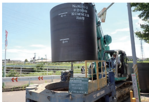
下水道整備の様子
