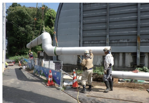
配水管の改修の様子
