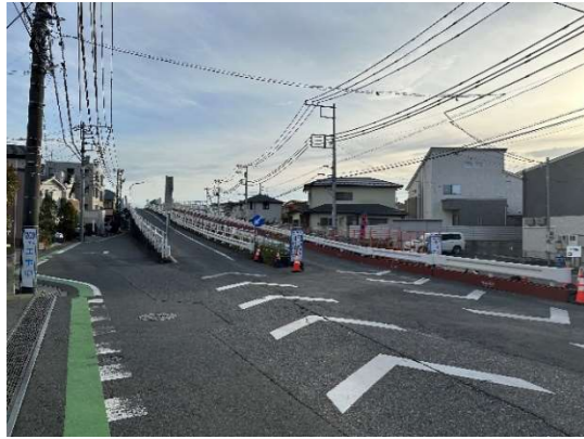
向小金1丁目側
