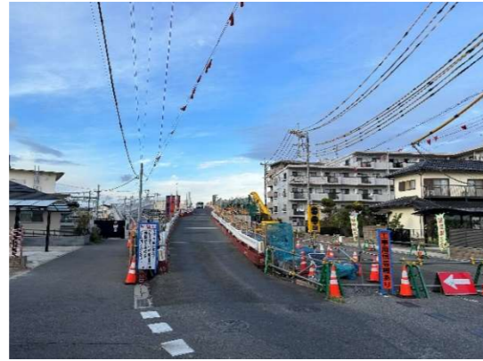
向小金2丁目側
