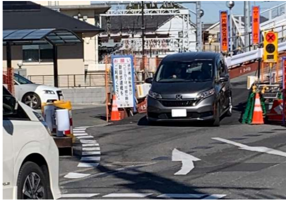
工事用信号による交通処理状況
