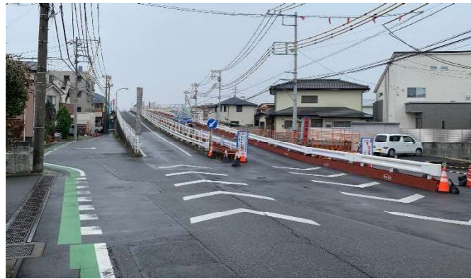
向小金1丁目側
