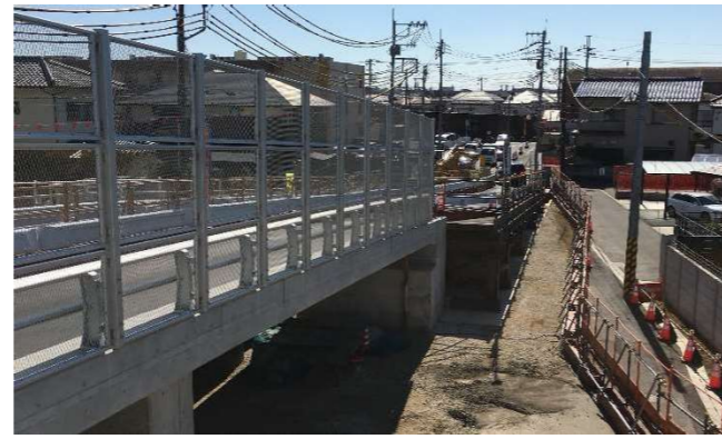
向小金2丁目側
