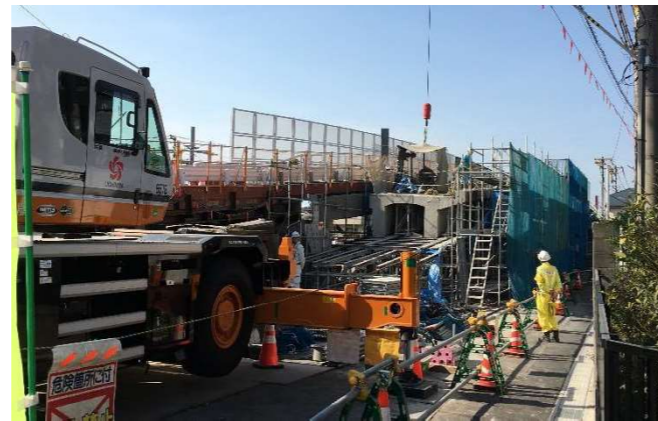
工事の施工状況(古い橋梁の撤去状況)
