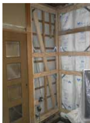
住宅の耐震改修
