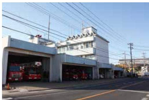
老朽化により移転予定の中央消防署
