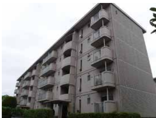
改修後の市営住宅柳田団地1号棟
